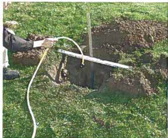
Vandmætning af jorden kan begynde. Der fyldes min. 0,20 m vand over gruslaget.
