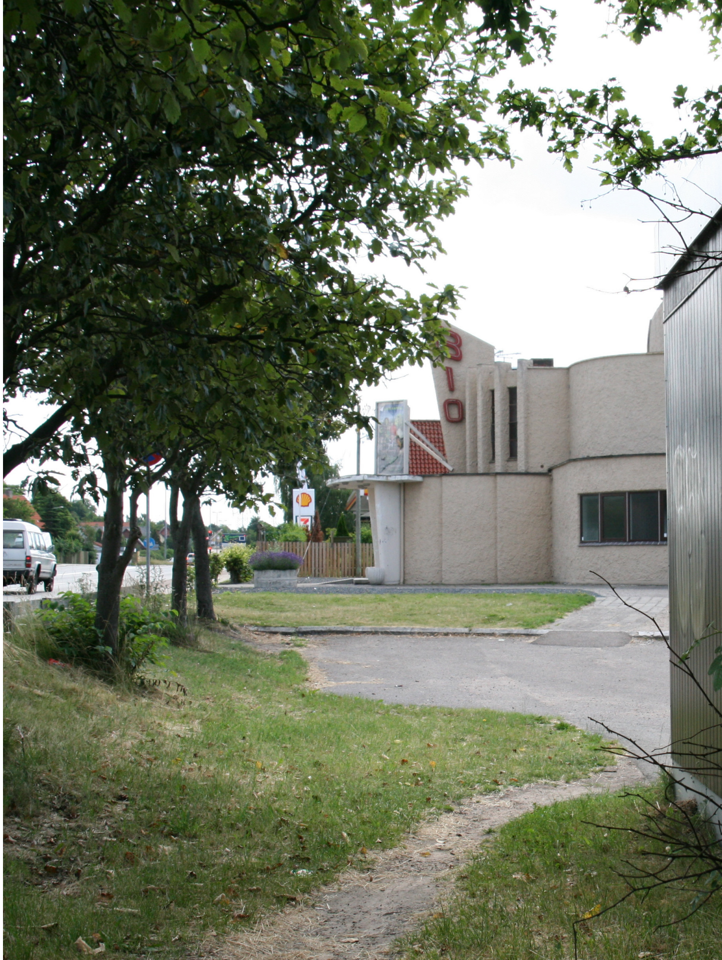
Region Hovedstaden renser grundvandet fra Frydensbergvej 4-6 i containeren ved Stenløse Biograf. Grundvandet er forurenet med klorerede opløsningsmidler, der stammer fra bla. En markisefabrik og en smede- og maskinfabrik i området. Grundvandet bliver pumpet op og renset gennem et kulfilter som står i containeren. Kulfiltrene fjerner forureningen og det rensede vand bliver ledt til Stenløse Å. Oprensningen forventes afsluttet i 2016.
