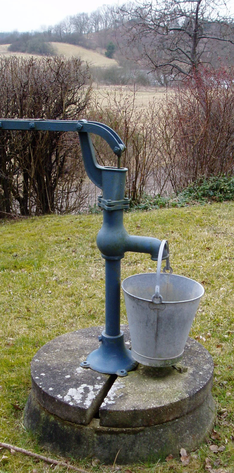
Ubenyttet brønd med håndpumpe og spand.
