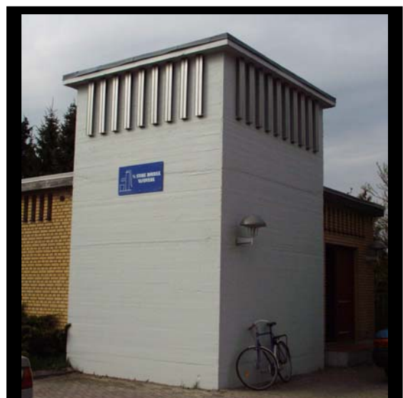
Store Rørbæk Vandværk
