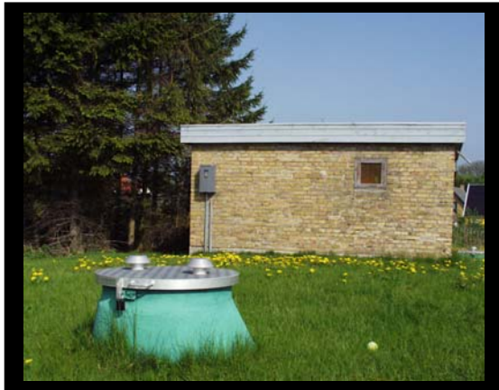
Oppe Sundby Vandværk
