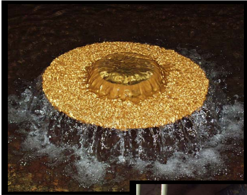
Billedet her til venstre er fra Marbæk Vandværk og viser iltet råvand der skal filtreres.
