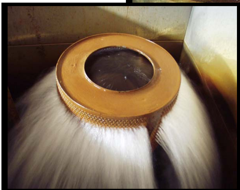
Billedet her til venstre viser iltningscentrifugen på Marbæk Vandværk.
