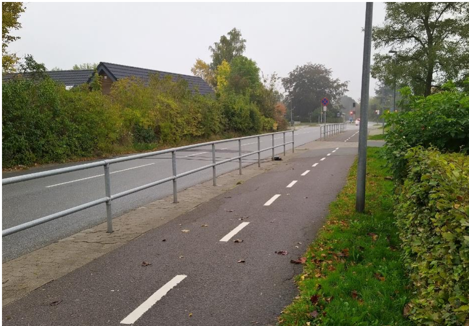
Billede 4: Oversigtsforhold i sydgående retning ad Råbrovej set fra placeringen for den kommende adgangsvej til Søagerhusene.
