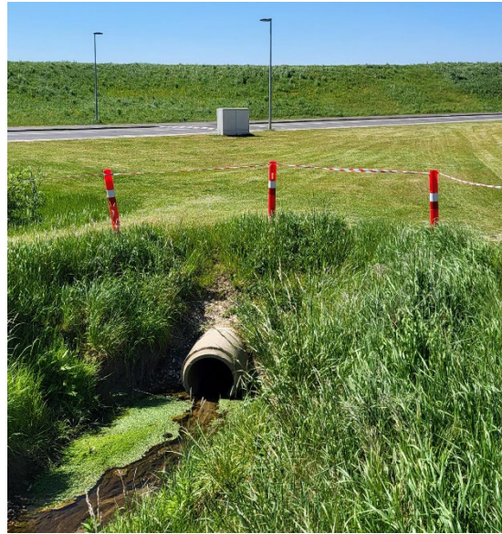
Figur 15 Rørlagt del af Smørumnedreafløb der løber under Schæfergårdsvej og Tværvæg
