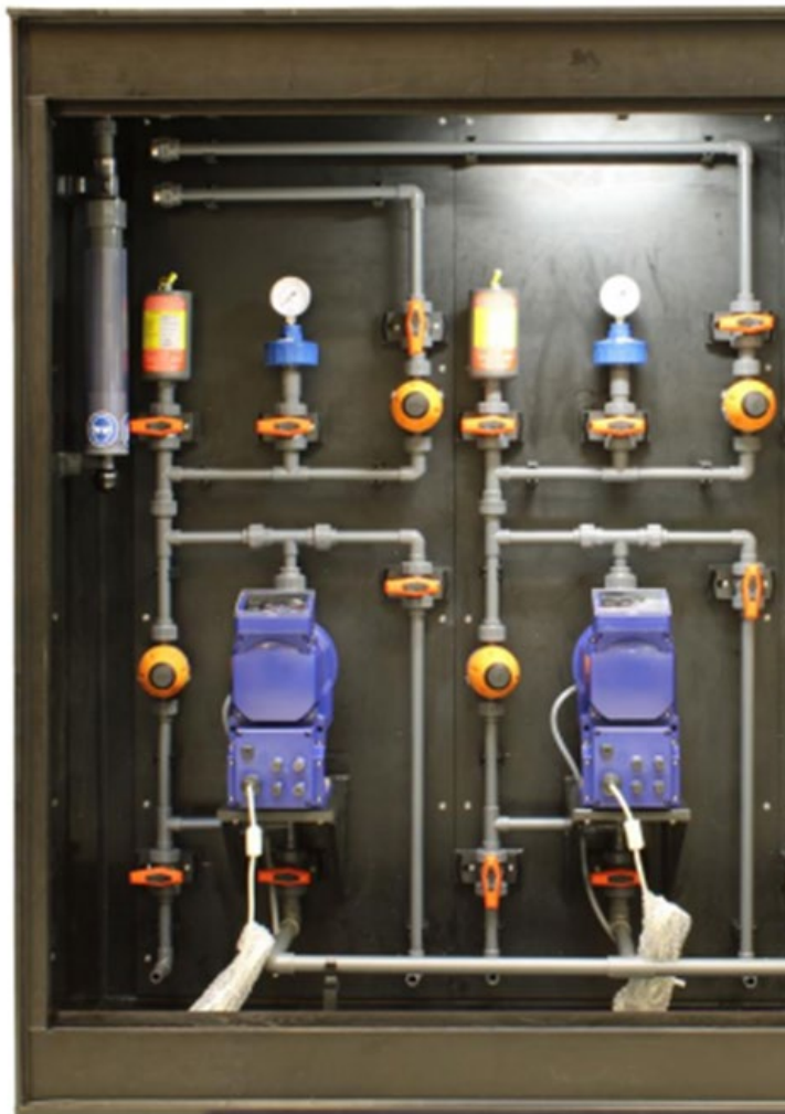
Figur 24 – Præfabrikeret kabinet for doseringspumper
