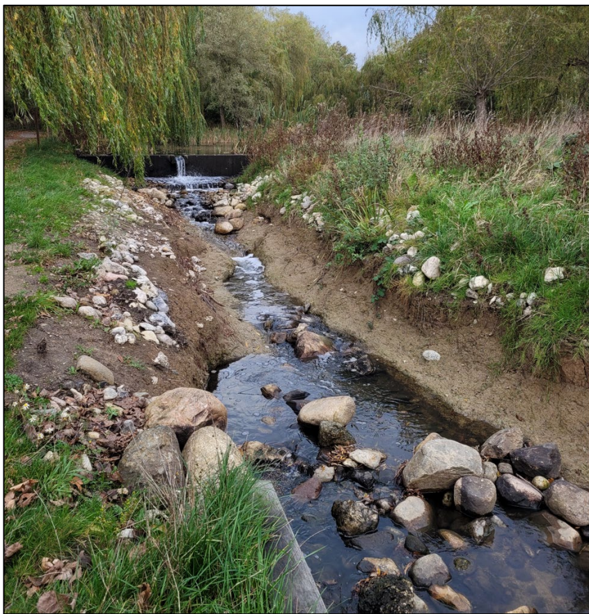
Figur 11 Reference på åben terrasseret grøft
