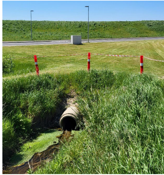
Figur 15 Rørlagt del af Smørumnedreafløb der løber under Schæfergårdsvej og Tværvej
