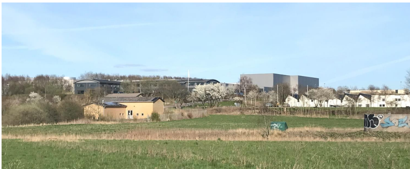
Figur 4.17: Det gule hus indeholder Region Hovedstadens afværgeanlæg for Cheminova/LYFA grunden. Det rensede vand ledes ud i Sørup rende, der ses i forgrunden. Desuden ses en af boringerne i området i den grønne kasse. Foto NIRAS.
