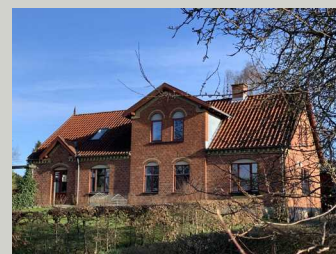
Det bevaringsværdige stuehus set fra haven
