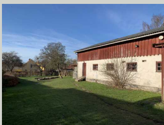
Den eksisterende trempebbebyggelse
