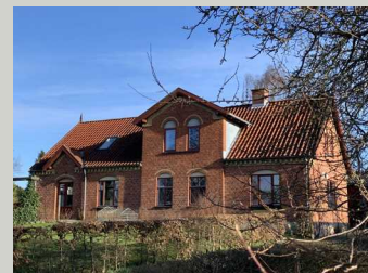
Det bevaringsværdige stuehus set fra haven
