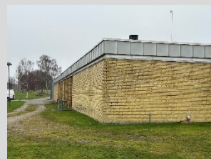
Eksisterende Ølstykke Vandværk
