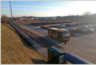
De stationsnære arealer med p-plads, busholdeplads og regnvandsbassiner.
