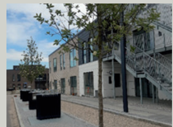
Eksisterende affaldssorteringsanlæg langs bygader
