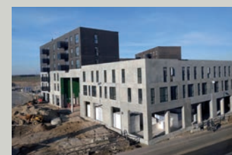
Boligbyggeriet "de grønne porte" hvor der er mulighed for erhverv i stueetagen
