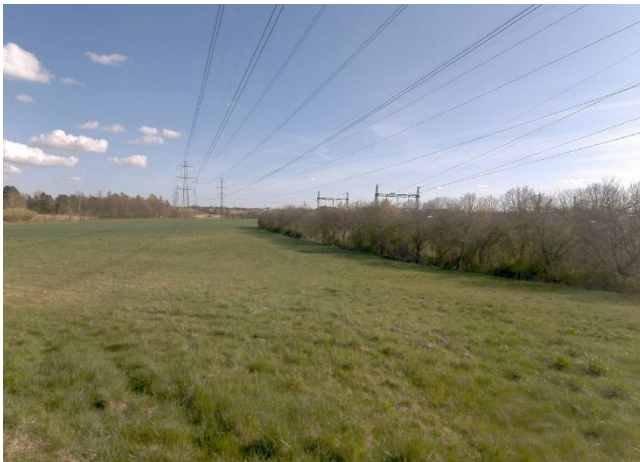
Foto 3: Mod nord ved Tostedvej ligger et stort tekniskanlæg (transformerstation) der er afgrænset af beplantning
