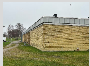
Eksisterende Ølstykke Vandværk
