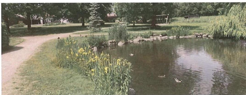
Figur 2 Foto af den del af stensætningen som ønskes renoveret (billede fra ansøgning).
