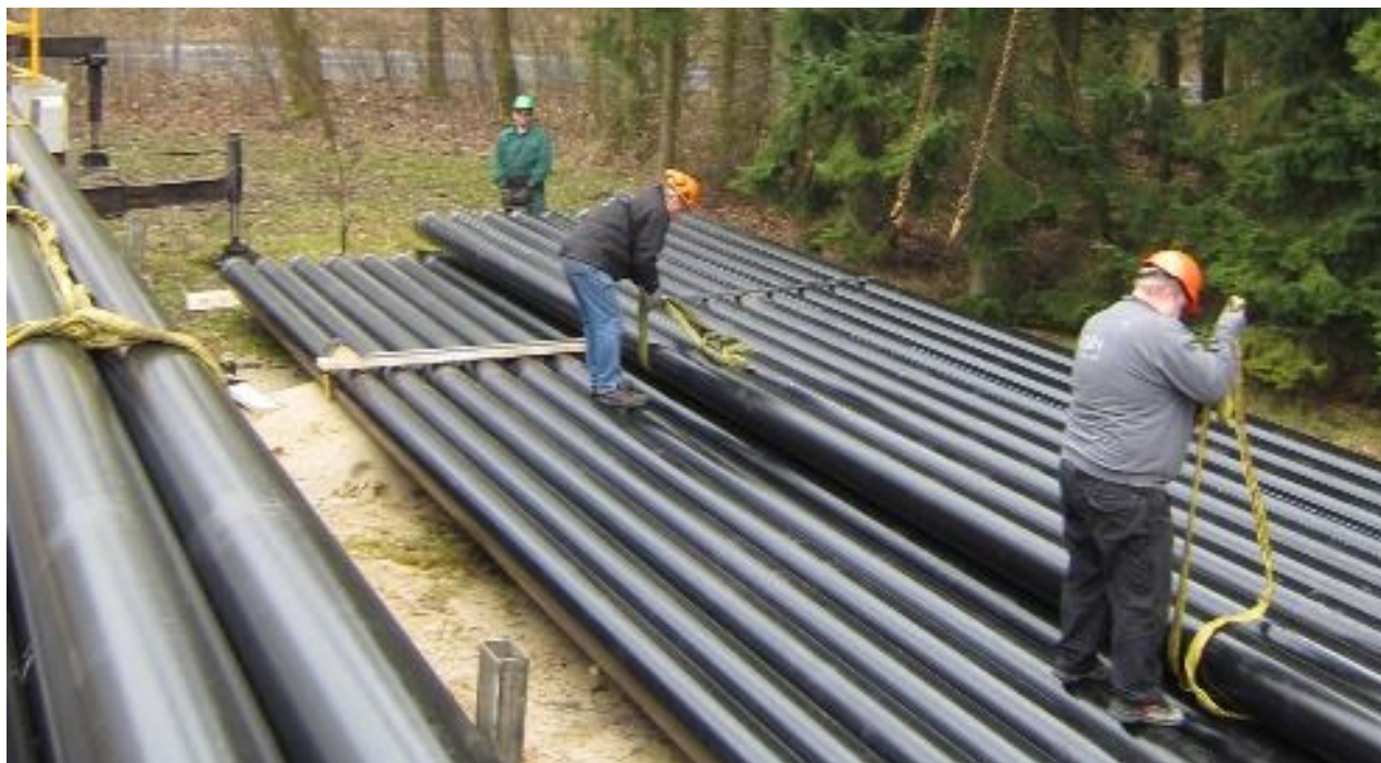
Figur 2.6 Håndtering af rør på rørlagerpladsplads
