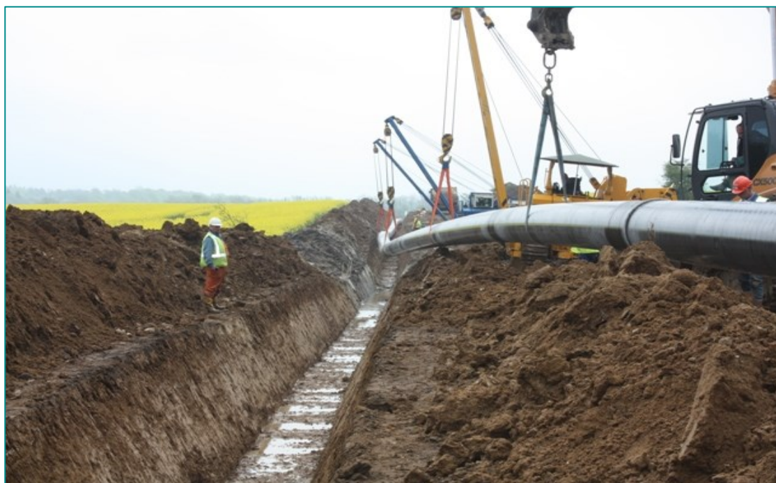
Figur 2.2 Nedlægning af gasledning i ledningsgrav
