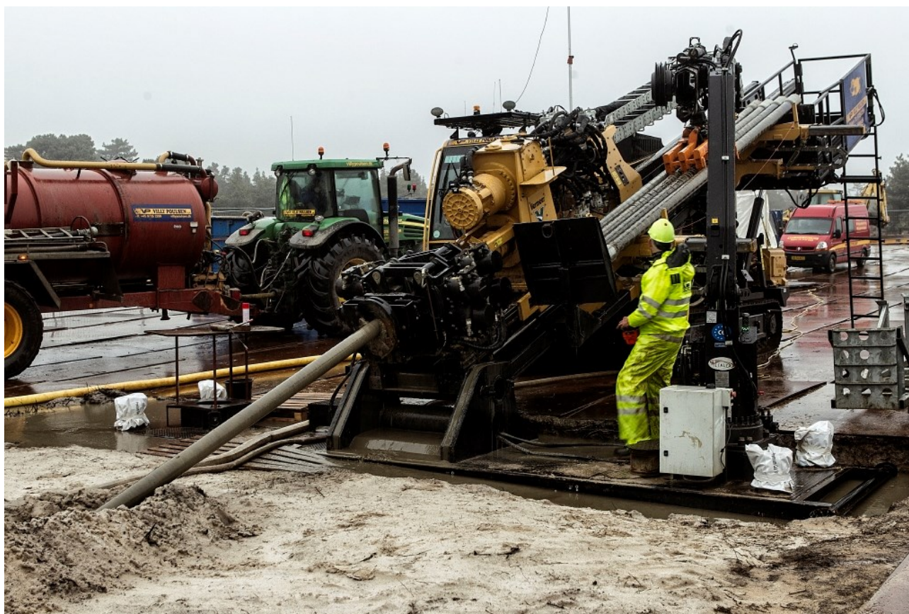
Figur 3.2 Eksempel på arbejdsareal ved styret underboring.
