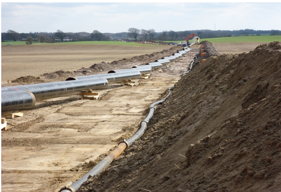
Figur 2.1 Rør udlagt i ryddet arbejdsbælte
