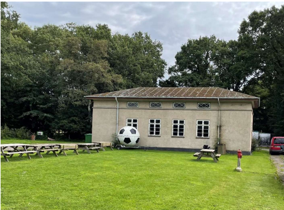
Figur 4.19: Bygning med pumpestationen ved arealreservationen for U25 bassinet. Foto: NIRAS.
